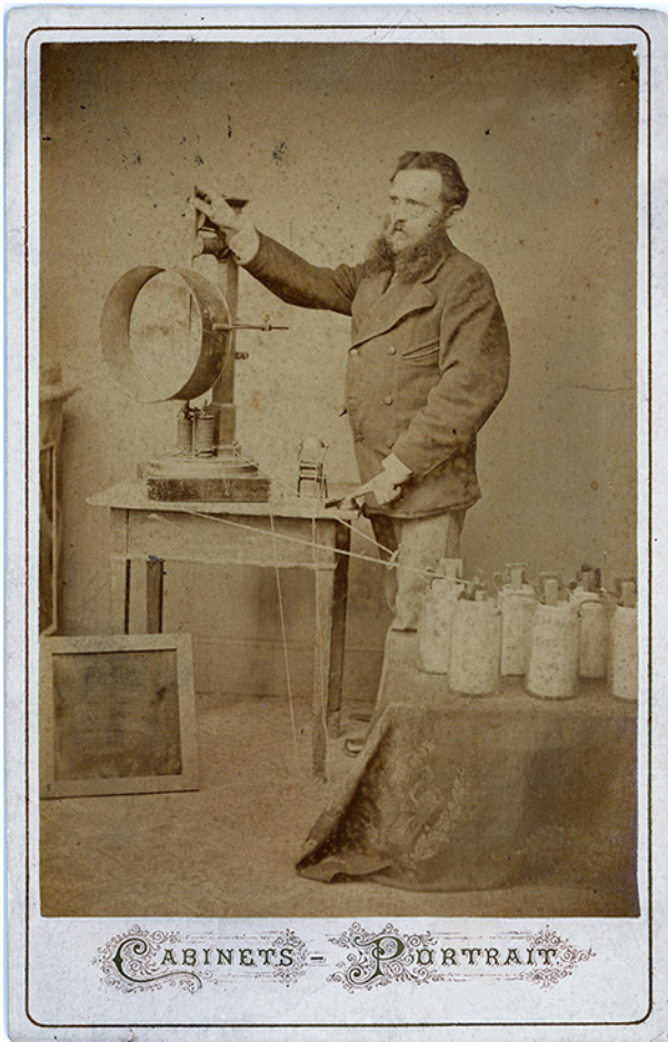
Abb. 9 Beleuchter Karl Hempel mit Kohlenbogenscheinwerfer bei Circus Renz. Fotografie im Kabinetformat (1881). Archiv Friedrichstadt-Palast.
